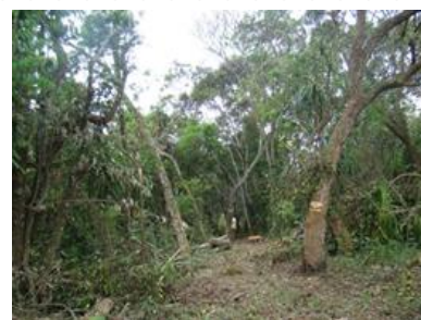
Figura 22 - Abertura de trilha (picada) para implantação de torres
