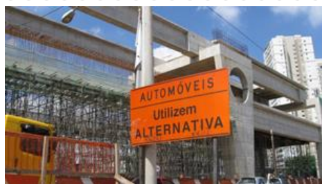
Figura 18 - Sinalização de obras de metropolitanos em viários
